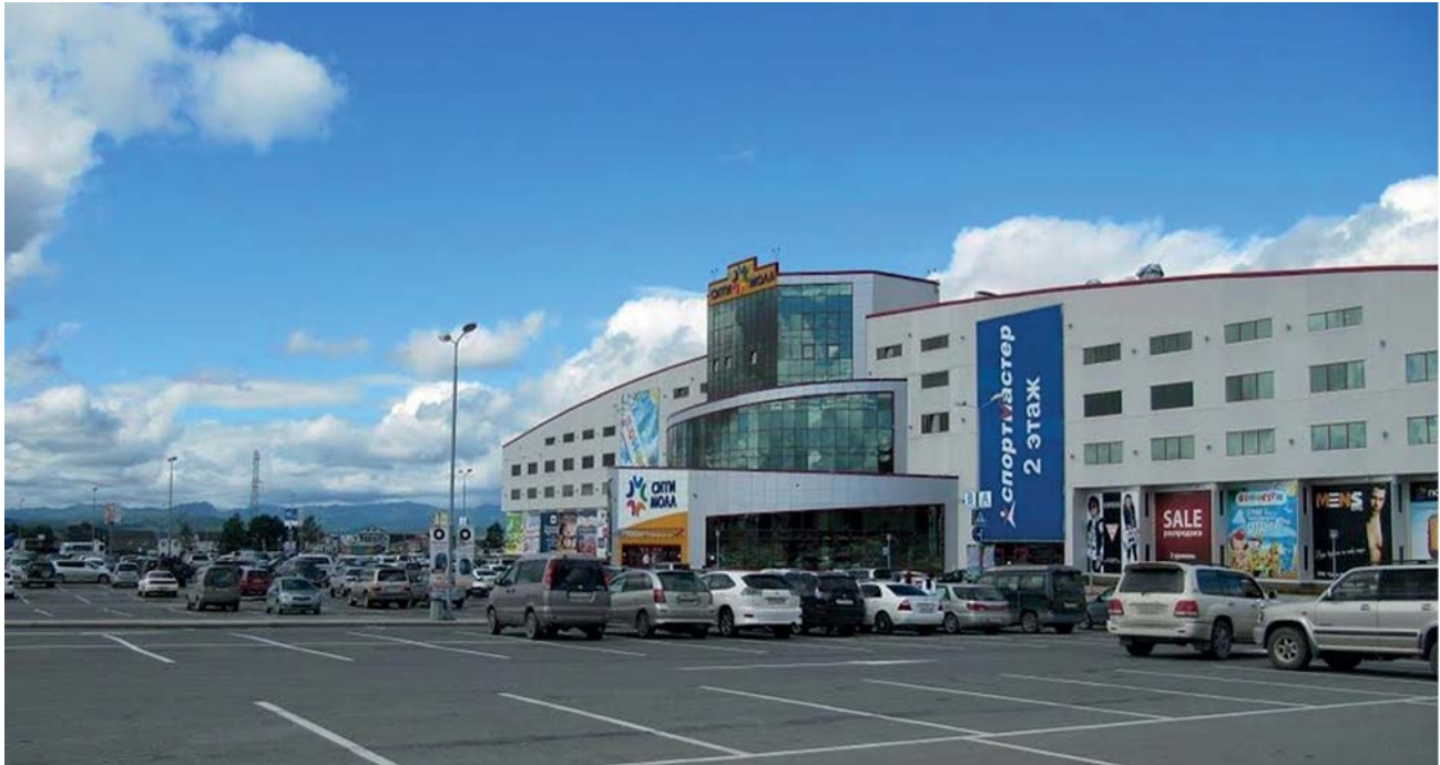
Торговый центр «Сити Молл», г. Южно-Сахалинск
